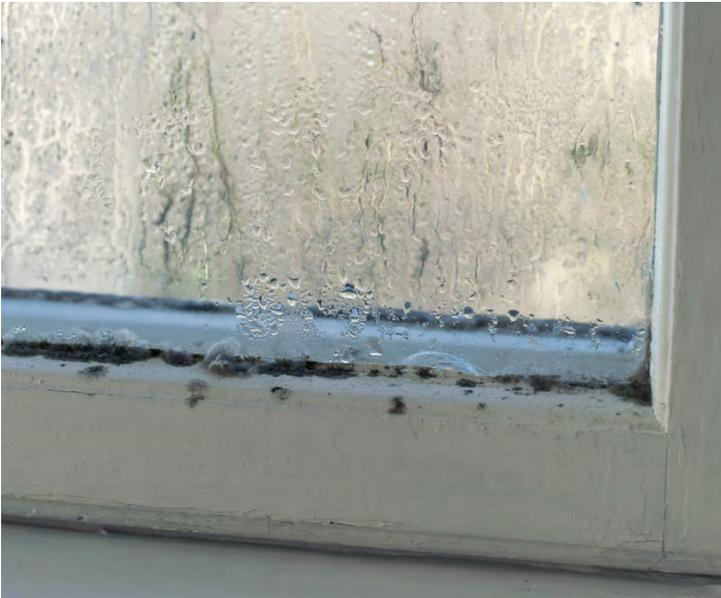
Abbildung 17: Kondensat auf Verglasung, vorzugsweise unten
