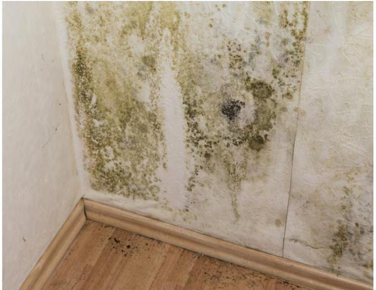
Abbildung 24: Schimmel in einer Außenecke (vor allem hinter Kästen)
